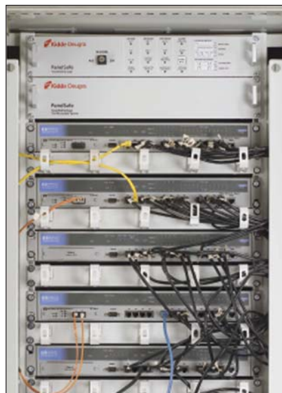
Einbau PanelSafe in 19"-Schrank
